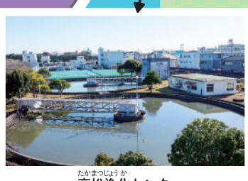
高松浄化センター
