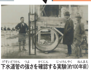
下水道管の強さを確認する実験(約100年前)
