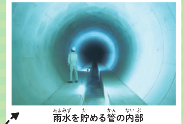
雨水を貯める管の内部
