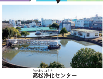
高松浄化センター
