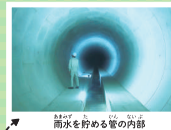
雨水を貯める管の内部
