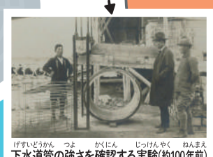
下水道管の強さを確認する実験(約100年前)
