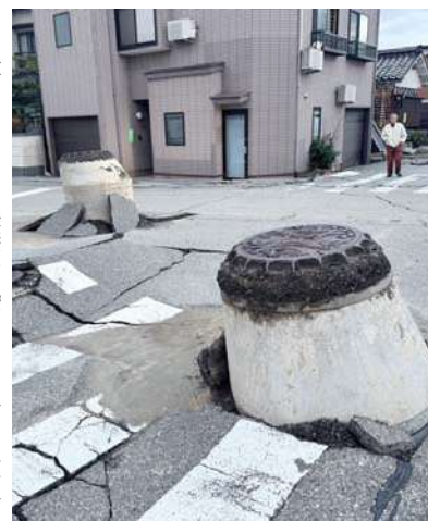
能登半島地震では上下水道施設にも大きな被害が発生した
